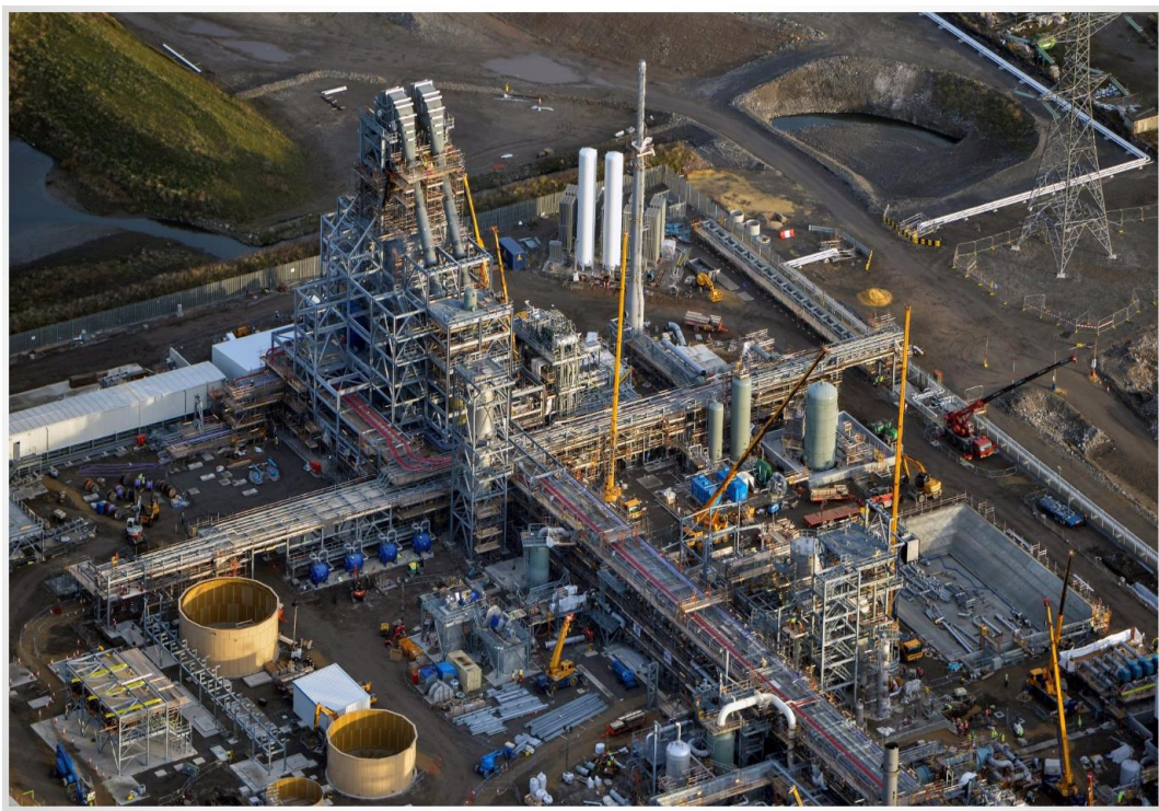
Obrázek 17 Výstavba zařízení TV1, Velká Británie. Zdroj PGP Terminal, a.s.
